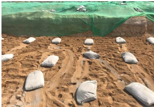
临时防尘网覆盖
