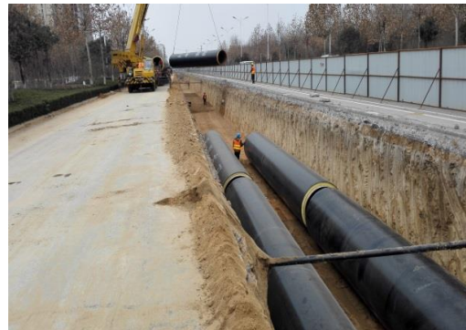
临时彩钢板拦挡
