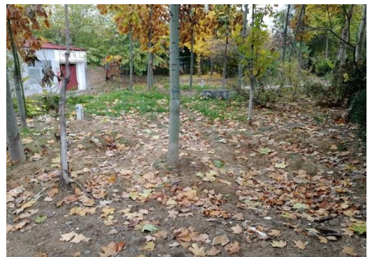
管线开挖绿地恢复
