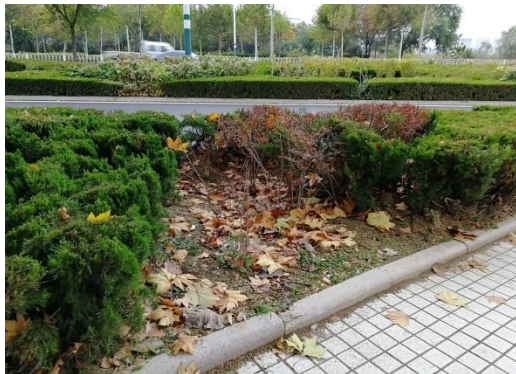
管线开挖绿地恢复
